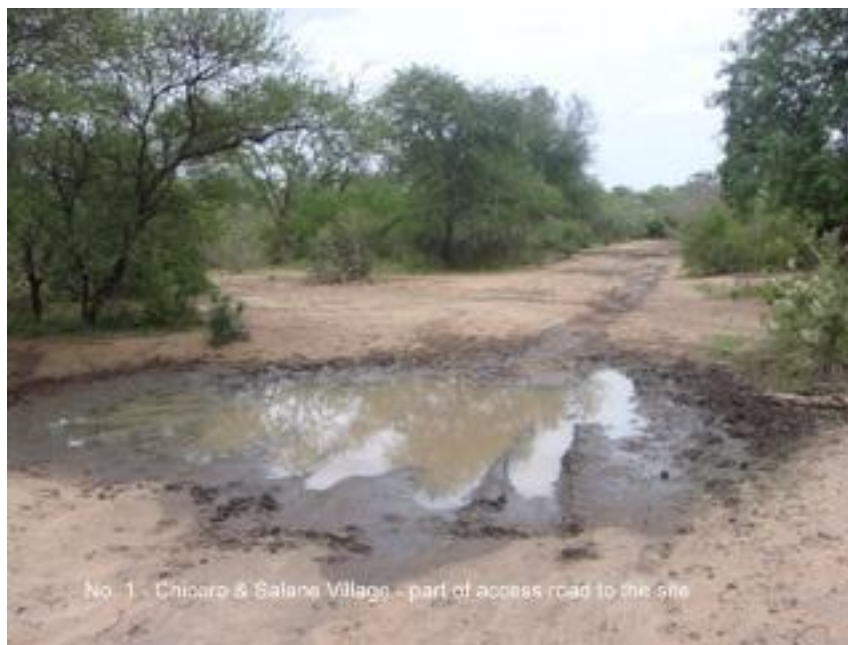
Nº 1 Aldeia de Chicoro & Salane – parte da Estrada de acesso ao local.
